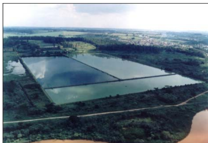
Figura 112 – Lagoas de estabilização
