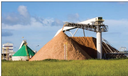
Figura 100 – Estocagem de cavacos
