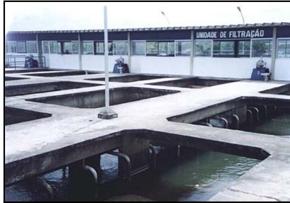
Fig. 2 - Unidade de Filtração – ETA.
