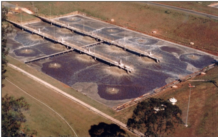
Figura 115 – Tanque de aeração com aeradores de superfície
